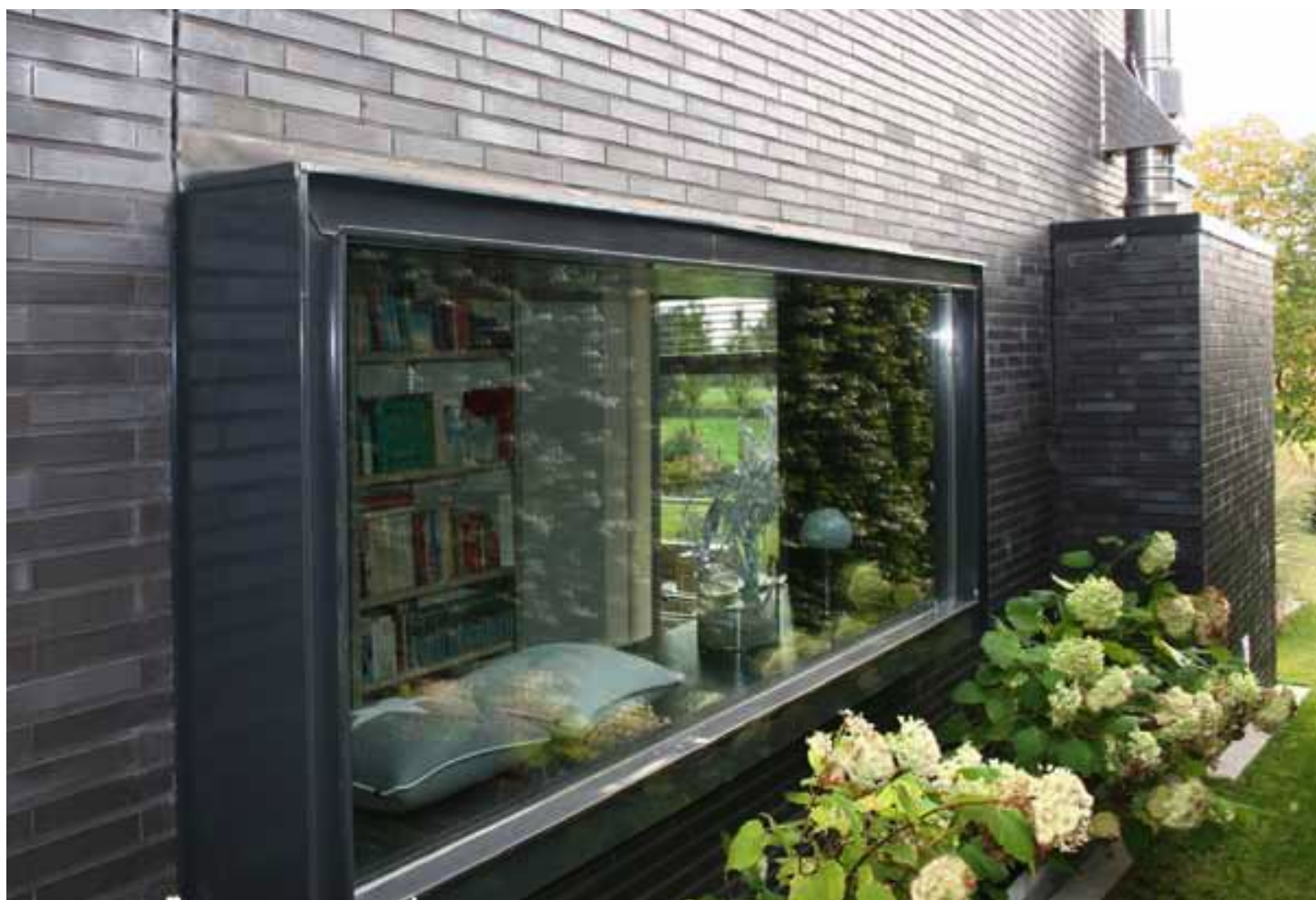
Anthrazit-farbener Hagemeister-Klinker der Sortierung „Alt Berlin“ verleiht dem Gebäude den Ausdruck von Sicherheit und Eleganz. Tagsüber ergibt sich auf der Fassade ein lebhaftes Lichtspiel. Foto: Hagemeister
