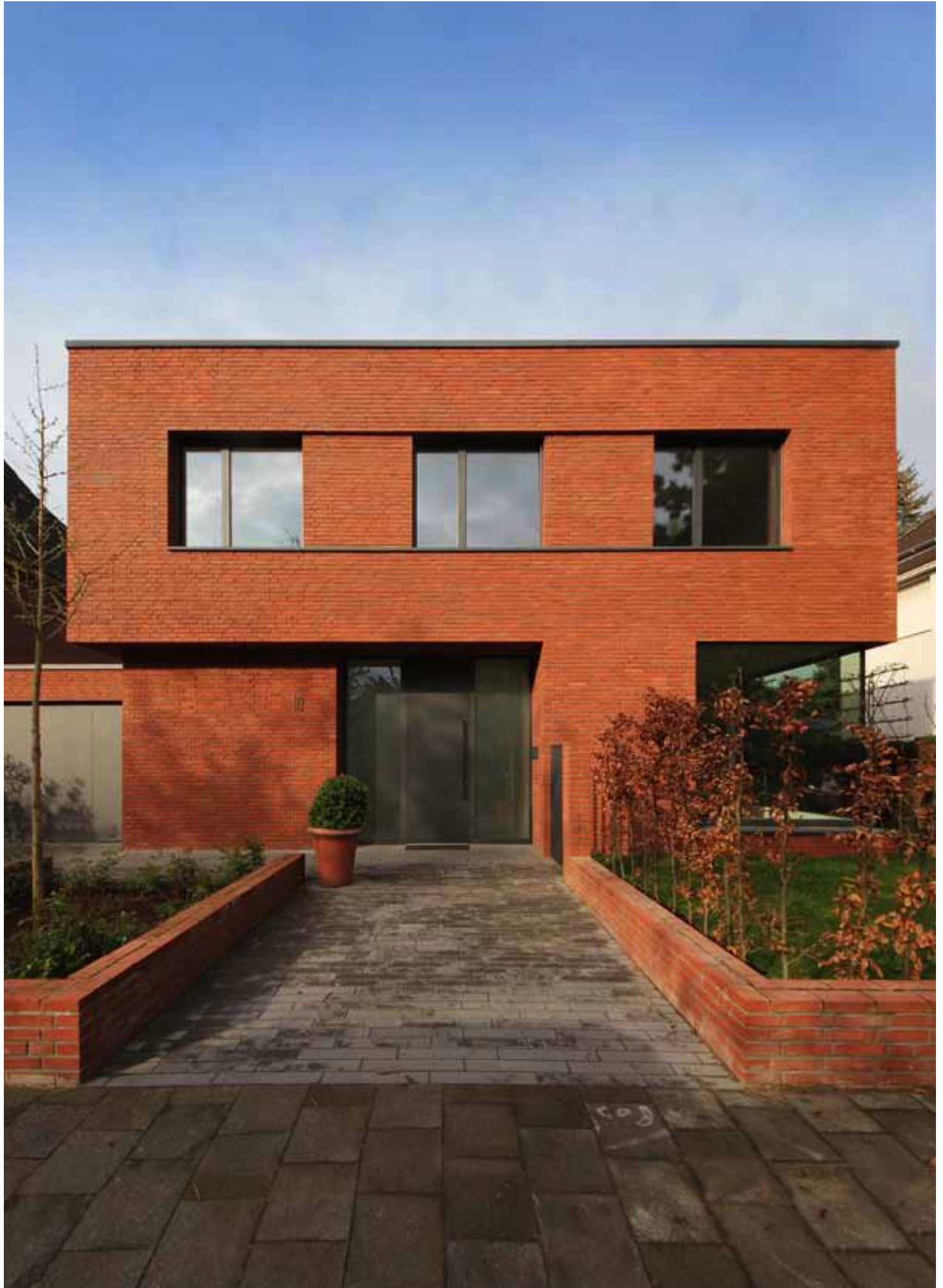
Der auf den ersten Blick schlichte Backsteinkubus besticht mit durchdachten Details: Vor- und Rücksprünge, tief eingeschnittene Öffnungen sowie die das Gebäude umgebenden Grünflächen, Bäume und Mauern stellen Bezüge zu der gegenüberliegenden Erphokirche her.
