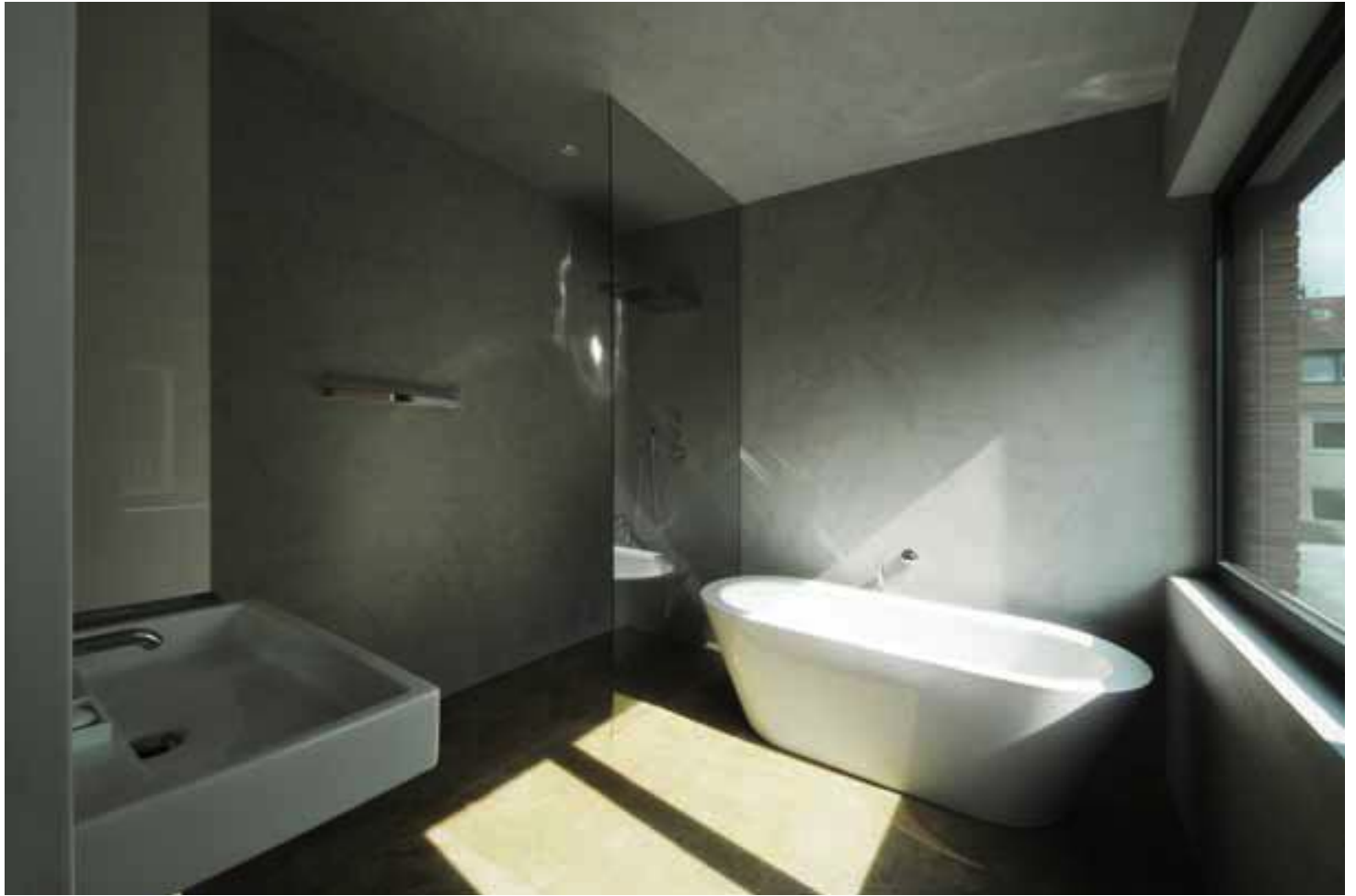
Im Bad wurde komplett auf Fliesen verzichtet. Die in Wand und Decke eingelassenen Duschwände sowie hochwertige Einzelobjekte reduzieren den Raum auf das Wesentliche.
