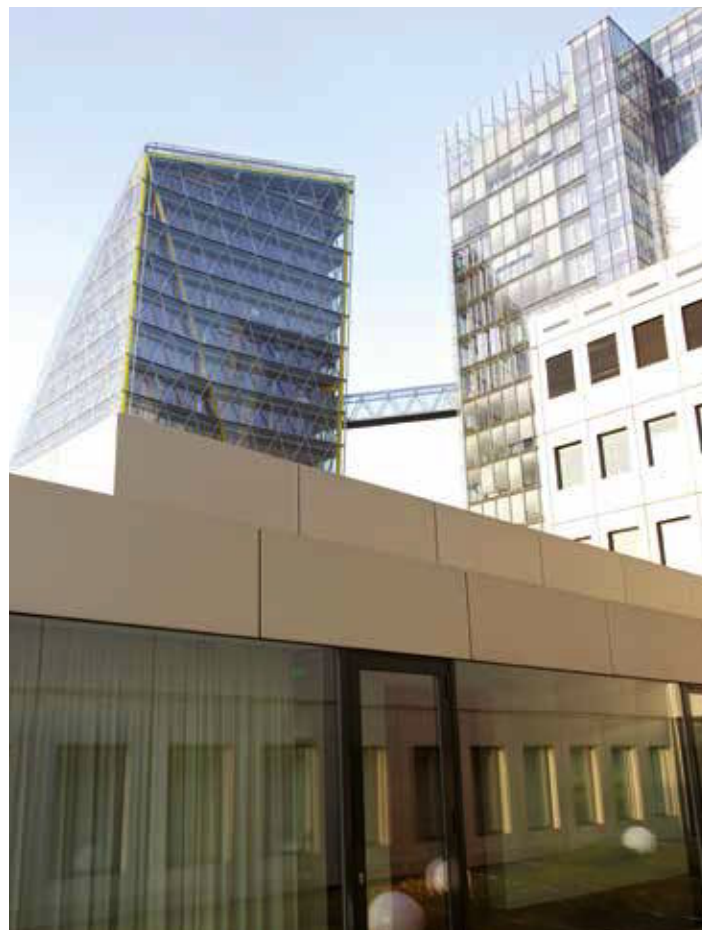
LVM Versicherung: mechanische Schließanlage und automatische Dreh- und Schiebetüren
