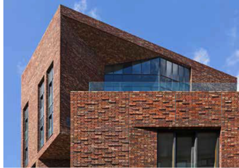
Wiederentdeckte Mauerwerkskunst - Durch Auslassen, Einrücken oder Herausschieben einzelner Klinker aus dem Verband entstehen haptisch erlebbare Fassaden.
