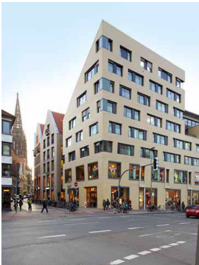
Alter Fischmarkt: mechanische Schließanlage, elektronische Zutrittskontrolle und automatische Dreh- und Schiebetüren
