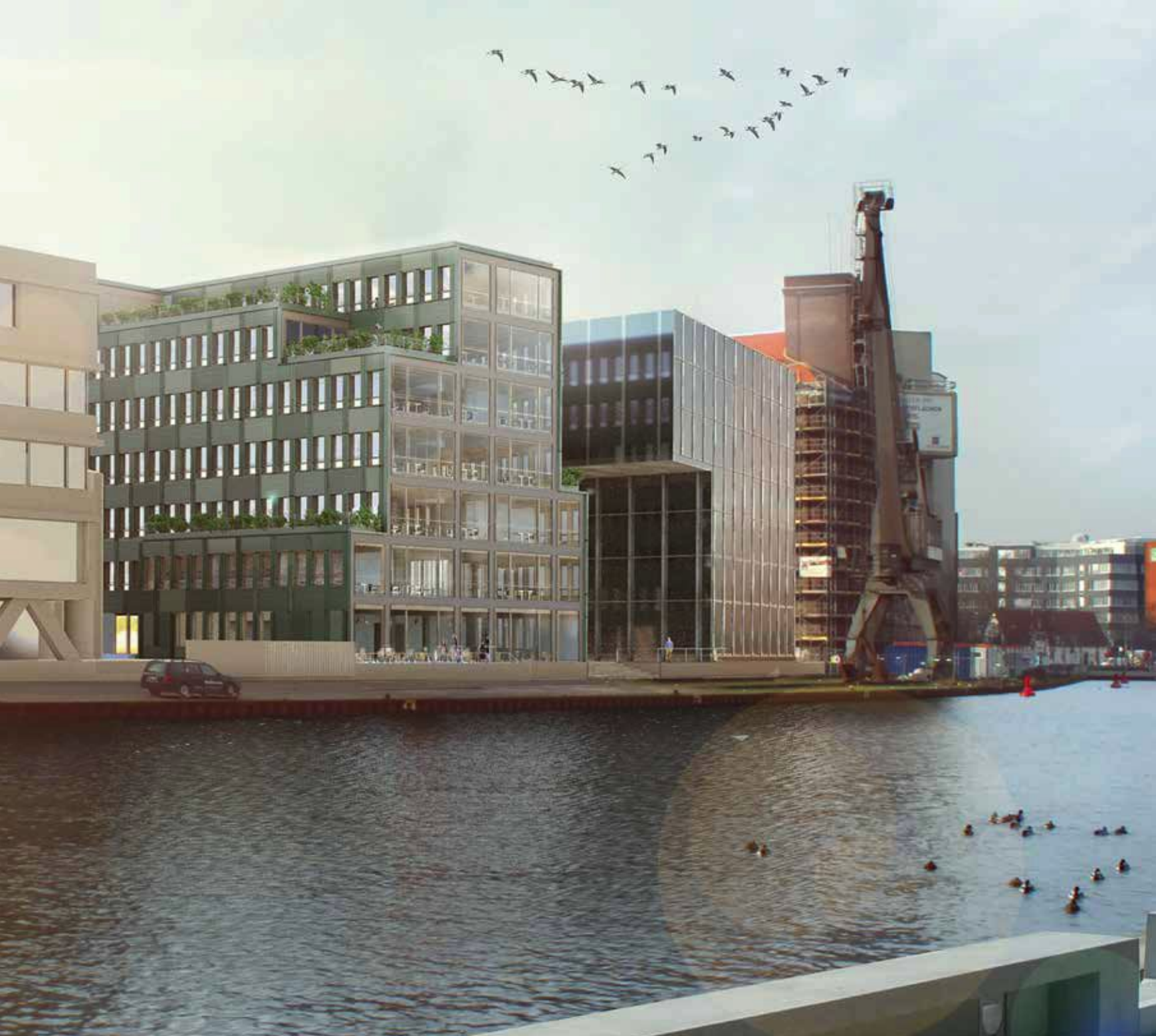
Die große Glasfassade erlaubt tiefe Einblicke in die Bauweise des H7 – hier von der Münsteraner Hafenseite aus betrachtet.
