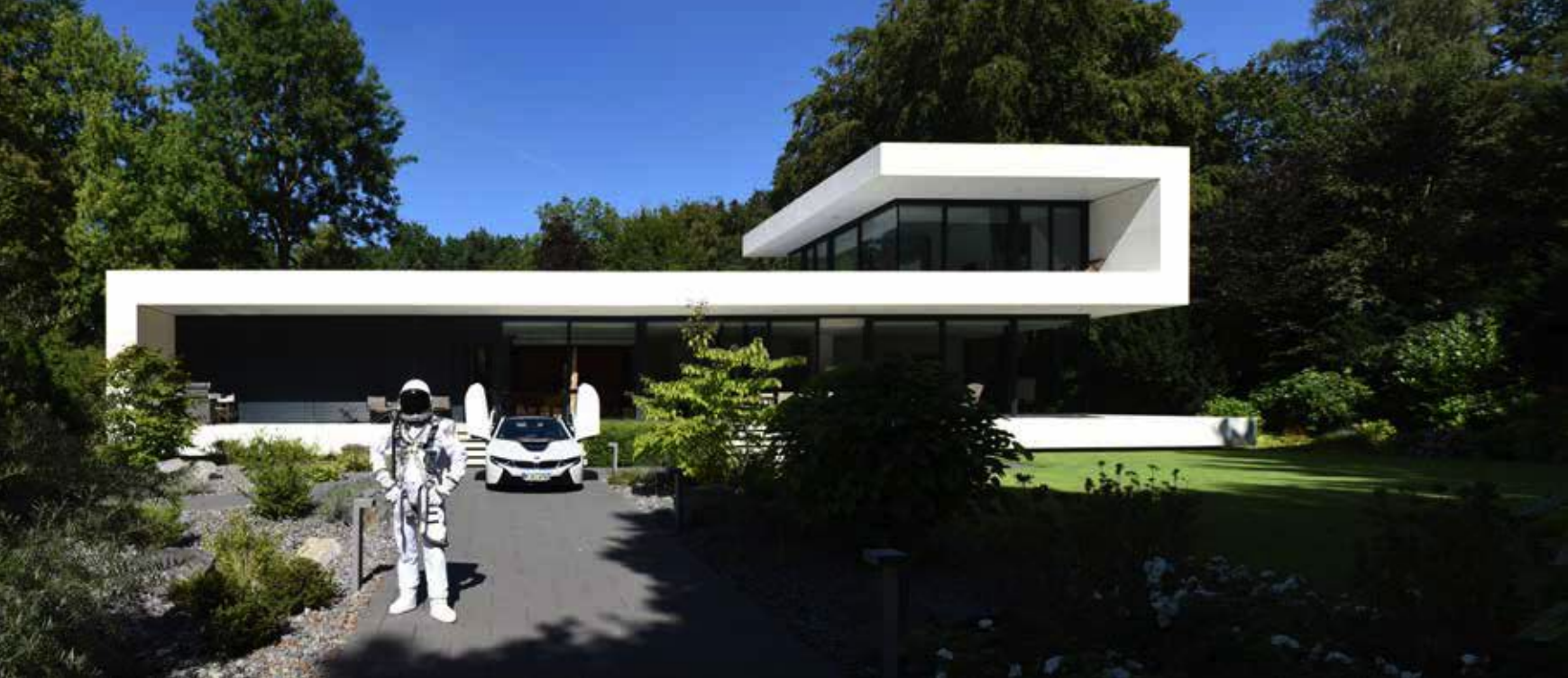
Außergewöhnlich und spacig: Der mäanderförmige Baukörper hat eine moderne, geradlinige Industriefassade aus weiß eloxierten Aluminiumplatten und ist weitgehend energieautark.
