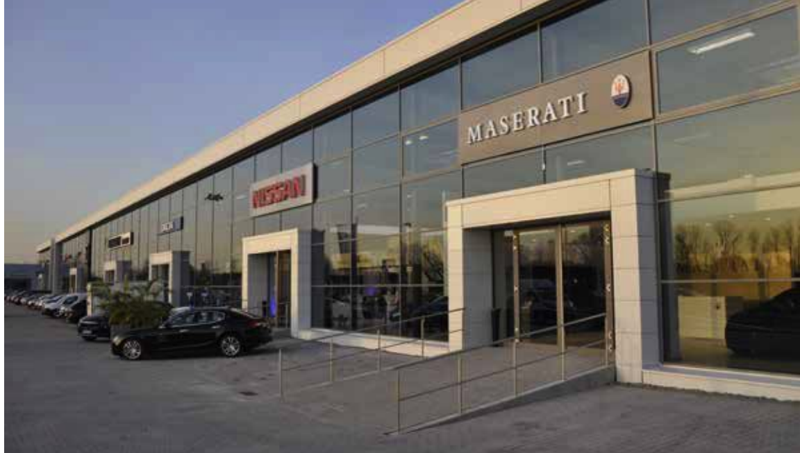
Schon vor dreieinhalb Jahren tätigte die Bleker Gruppe mit dem Neubau des Autoforums Münster die mit 7,5 Millionen Euro größte Investition in ihrer Geschichte. Jetzt integrierte sie mit einer Gebäuderweiterung Nissan und Maserati in ihr erfolgreiches Mehrmarkenkonzept.
