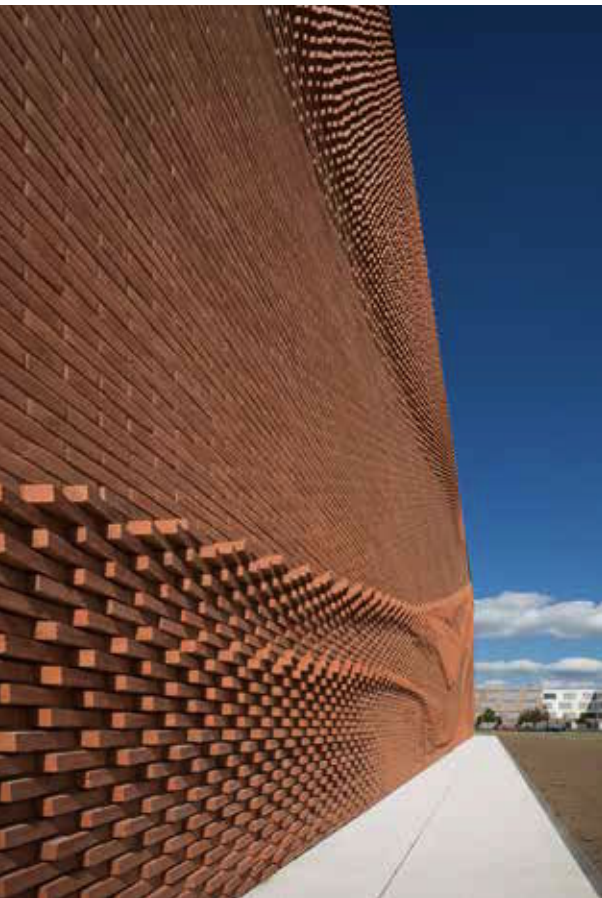
Fassade mit textiler Anmutung: Die differenzierten Tiefen der sechs speziell entwickelten und angefertigten Ziegelsteine reflektieren den Himmel völlig unterschiedlich und lassen ein ständig neues Spiel von Licht und Schatten entstehen.
