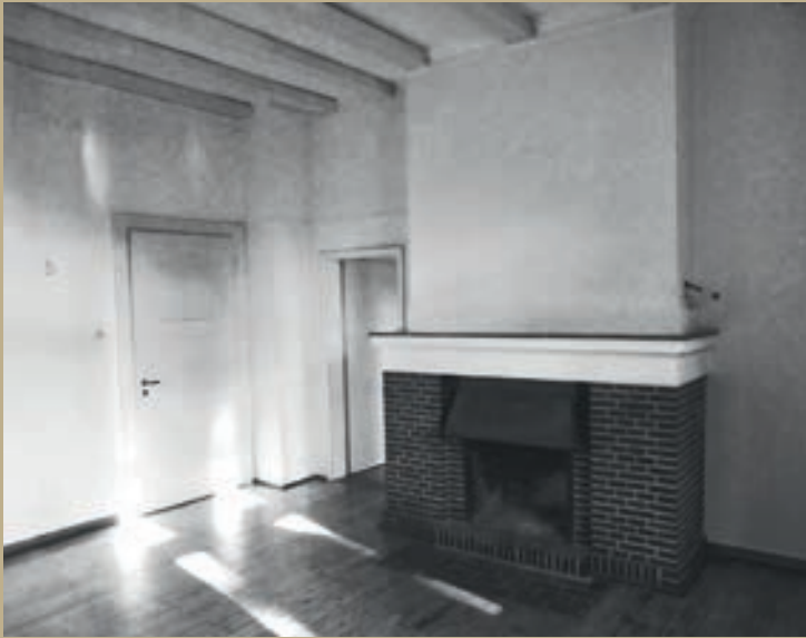
Bei dem bestehenden Kamin im Altbau (Zustand vor der Sanierung) arbeiteten Klapproth Architekten 1922 das Gewändemotiv heraus, was den Gründerzeitcharakter noch besser erlebbar macht.
