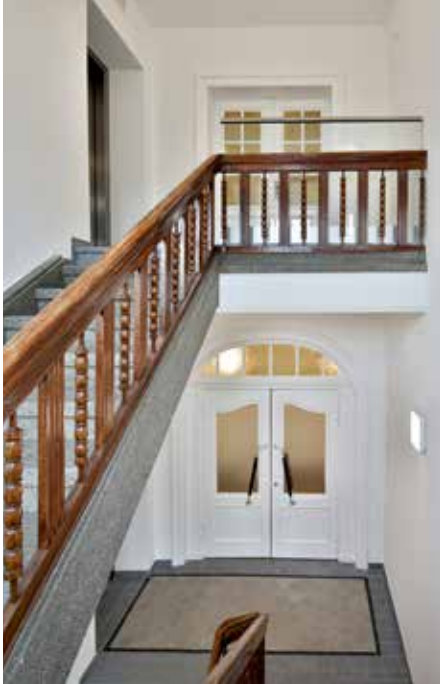
Alte Baumaterialien bewahrt: Die Fliesen im Eingangsbereich konnten aufgearbeitet werden.
