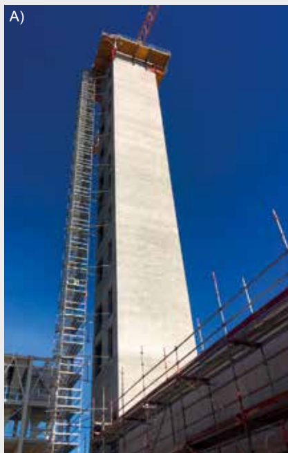
A) Erstellung Treppenturm in Gleitschalung, B) Neubau Produktionshalle in einer Größe von über 250 Einfamilienhäusern, C) Schlüsselfertige Erstellung eines Vollsortimenters inklusive Außenanlagen
