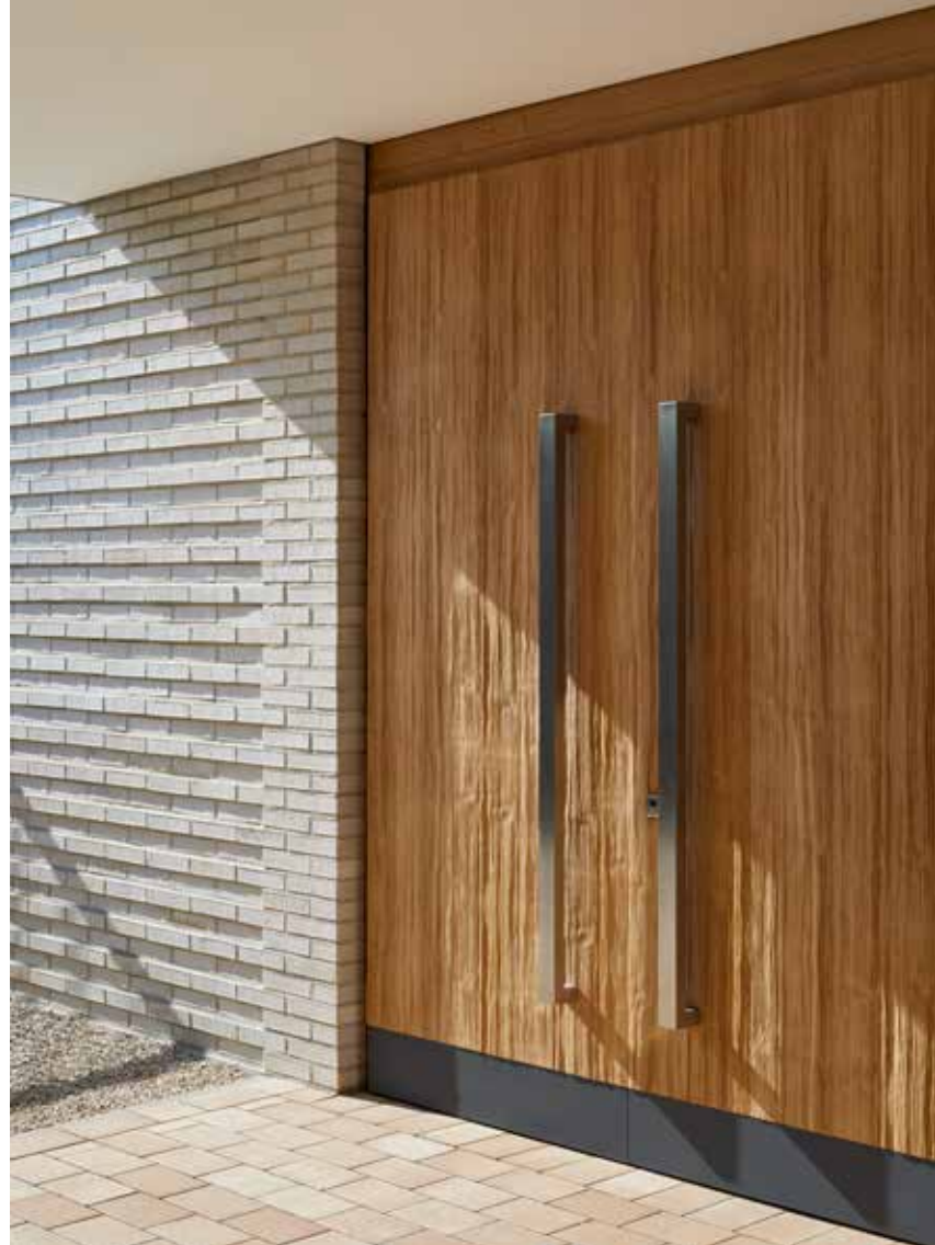
Die tiefenstrukturierte Oberfläche der Tür aus geprägter Eiche harmoniert sehr einfühlsam mit dem Charakter des Klinkers.
