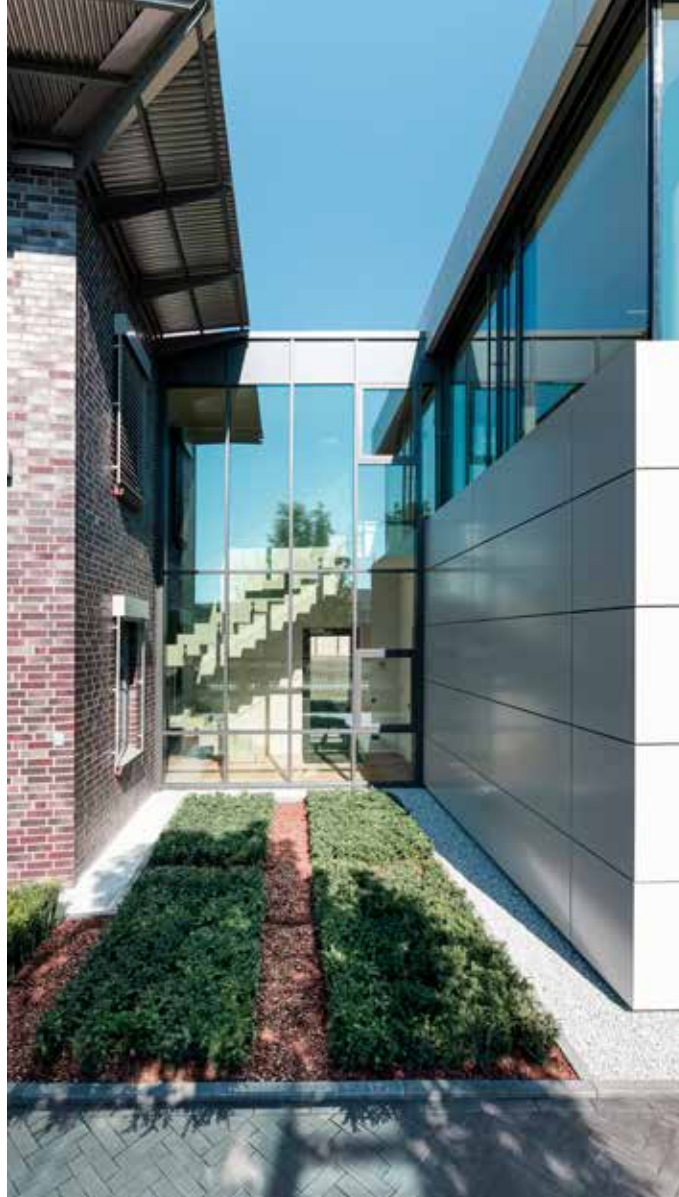
Die Verbindung des Anbaus zum Bestand bei gleichzeitig klarer Ablesbarkeit von Alt und Neu sowie die Verbindung zwischen außen und innen bestimmen das unverwechselbare Erscheinungsbild des Gebäudes.
