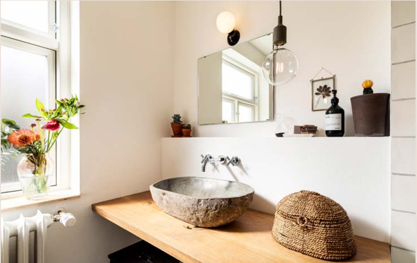
Ebenfalls ein Unikat: Kombination aus massiver Eiche mit Waschtisch aus Flusststein. Behandelt ist die Holzoberfläche mit einem wasserabweisenden 2-Komponenten-Öl.
