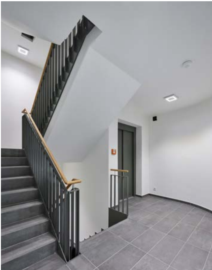
Unten: Für den barrierefreien Zugang wurden insgesamt vier Schindler-Personenaufzüge mit zwei bis sieben Haltestellen eingebaut.
