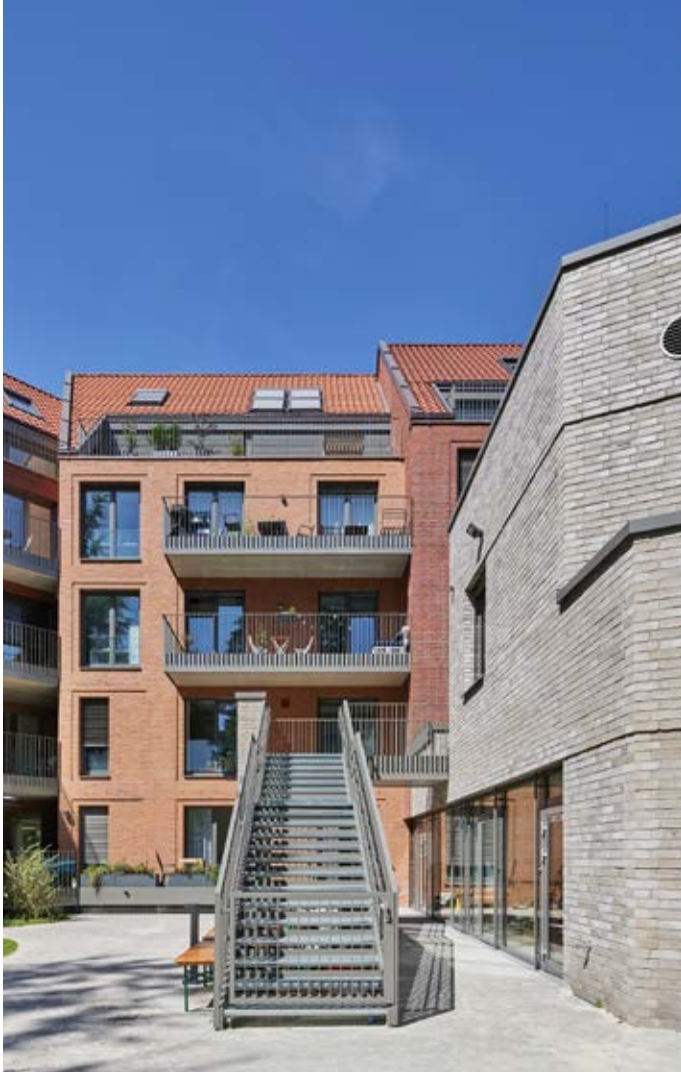
Oben: Der von der Klinkermanufaktur Janinhoff hergestellt und gelieferte Klinker wurde von Rheder Klinker & Fassadenbau verarbeitet.
