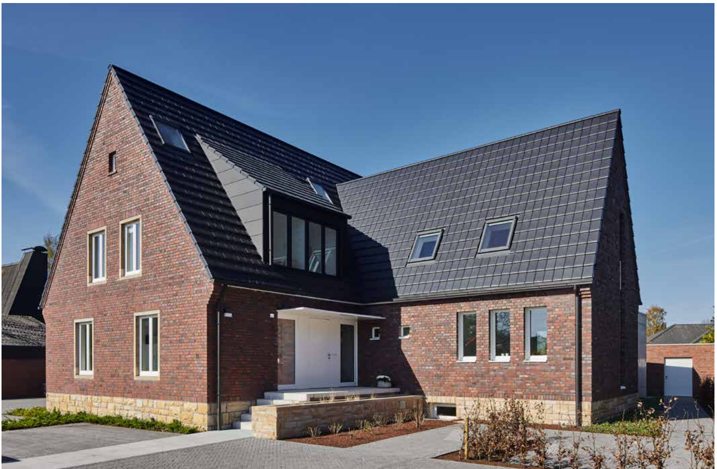
Würdigung des Alten im Neuen: Um marode Teile des Bestandes zu ersetzen, wurde das 50 Jahre alte Gebäude nahezu vollständig abgetragen und unter anderem mit ursprünglichen Materialien wie gereinigten Verblendersteinen wieder aufgebaut.
