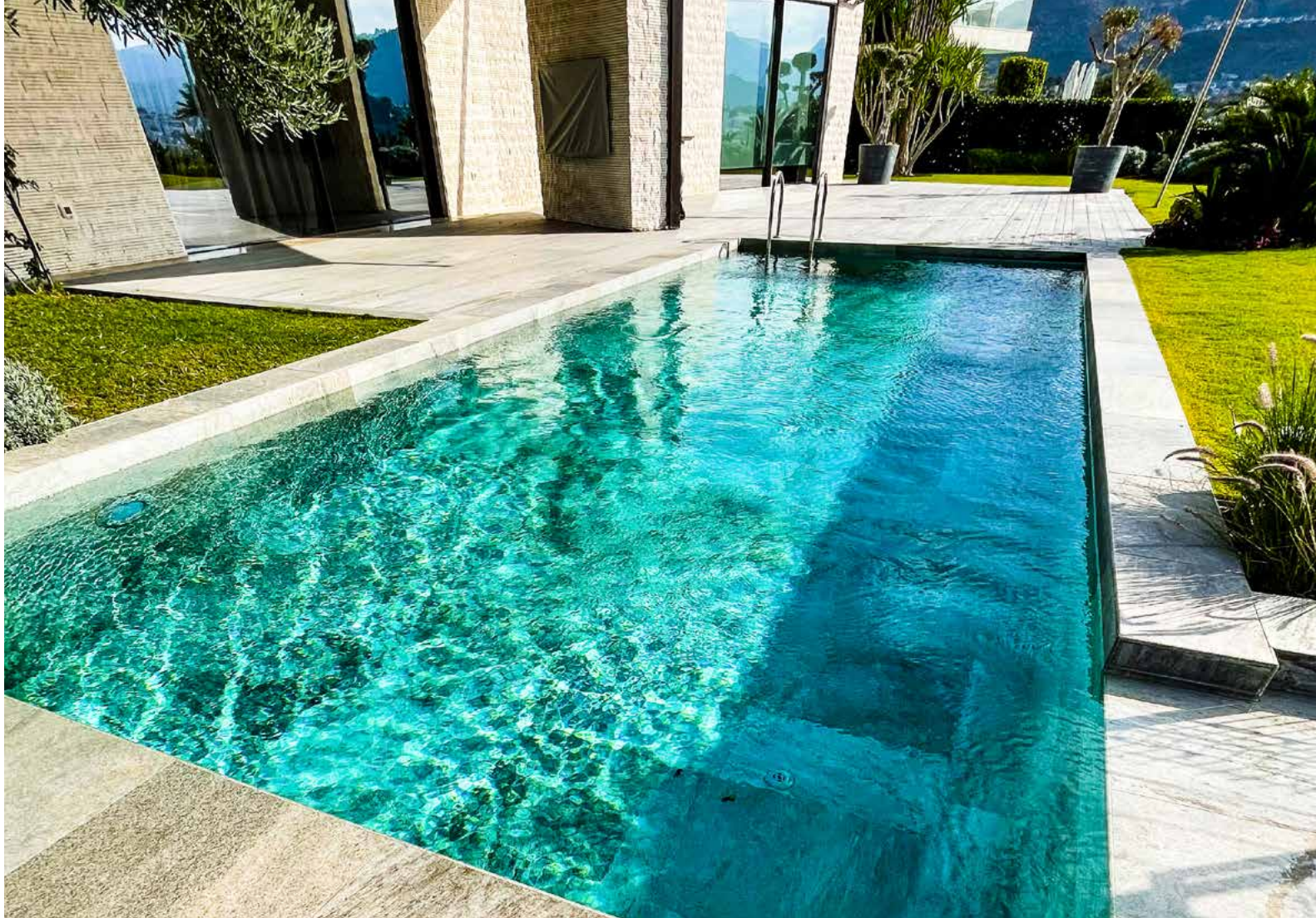
Die technischen Fliesen für Pools sehen aus wie Naturstein, sind aber Keramikfliesen mit einer lasierten Oberfläche. Es gibt sie in beliebigen Formaten von 30 x 60 cm bis 180 x 360 cm und vielfältigen Farben.
