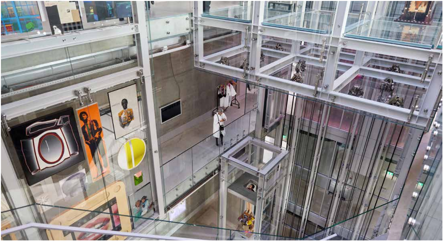
Die MWE Edelstahlmanufaktur entwickelte und fertigte mit dem MWE-Pivot-System im XL-Format eigens für das Depot individuelle Beschlagsysteme, die für die bis zu fünf Meter hohen Glasvitri- nen zum Einsatz kamen.
