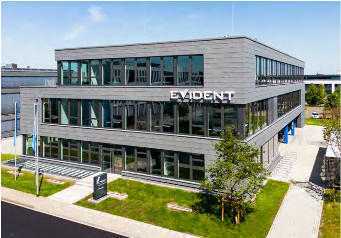
Auch zurückspringende Geschosse und Eckfenster lassen sich problemlos mit der Goldbeck-Systembauweise realisieren.
