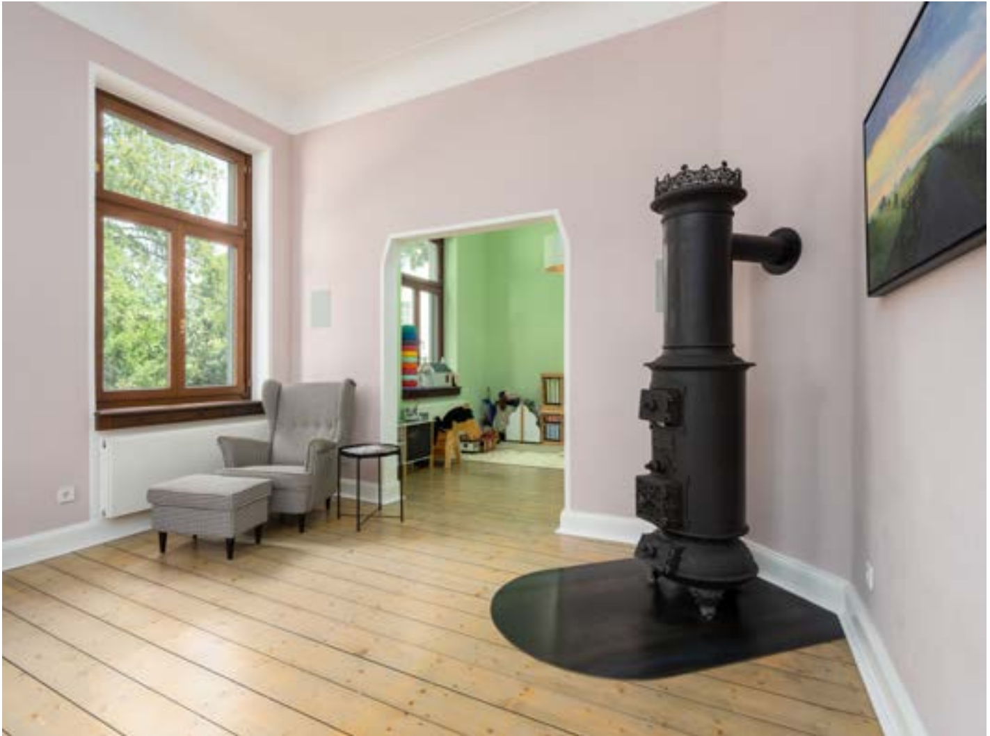
Eine Fußbodenheizung kam nicht infrage, um die historische Holzdielenkonstruktion erhalten zu können. Hierbei handelt es sich um Dielen aus amerikanischer Kiefer (Pitch Pine).
