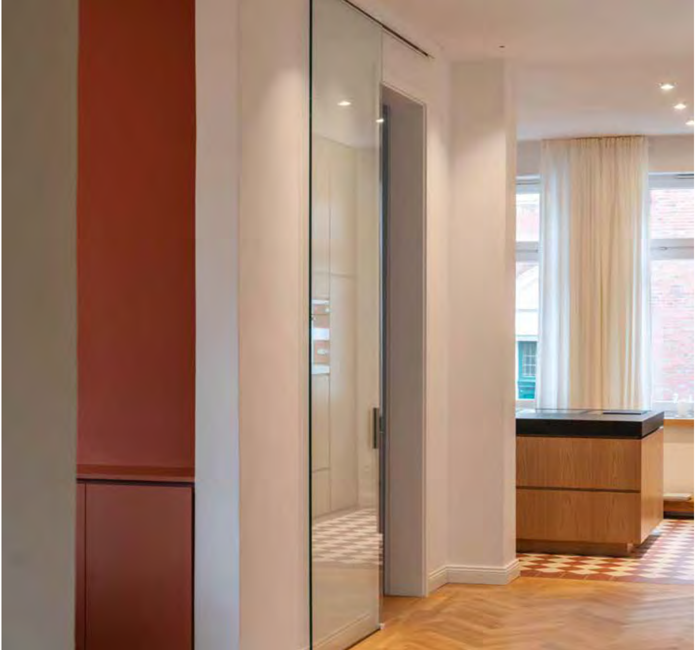
Unter anderem verschiedene Boden- und Treppenbeläge machen die Räume von Alt- und Neubau unterscheidbar. So etwa der historische Dielenboden und der zweifarbige Kachelboden der Küche im Neubau.
