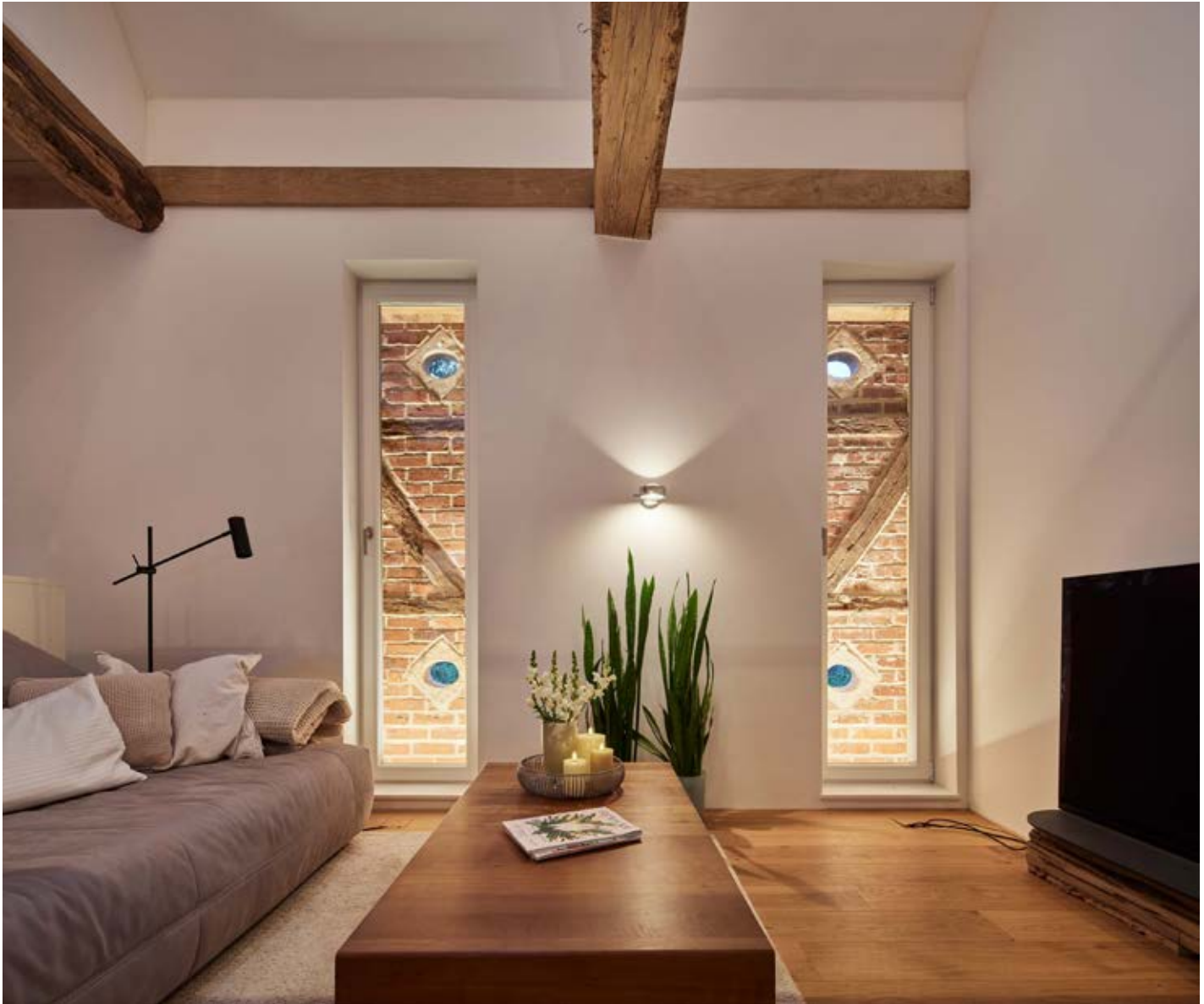
Traditionelle Zimmermannsarbeit mit innovativem Holzbau: Im Wohnbereich der Bochnias setzte das Team von Heinrich Haveloh alte, eingelagerte Eichenbalken ein, die in einer statisch und optisch präzise abgestimmten Konstruktion mit Rundrohrstützen kombiniert wurden.
