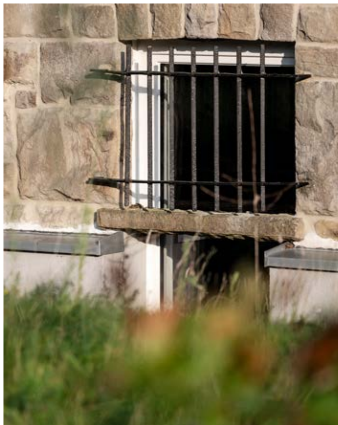
Die Fensteröffnungen der ehemaligen Arrestzellen wurden auf die doppelte Höhe vergrößert. In der Fenstermitte blieb die alte Sandsteinfensterbank stehen. Sie markiert die ursprüngliche Fensterhöhe.
