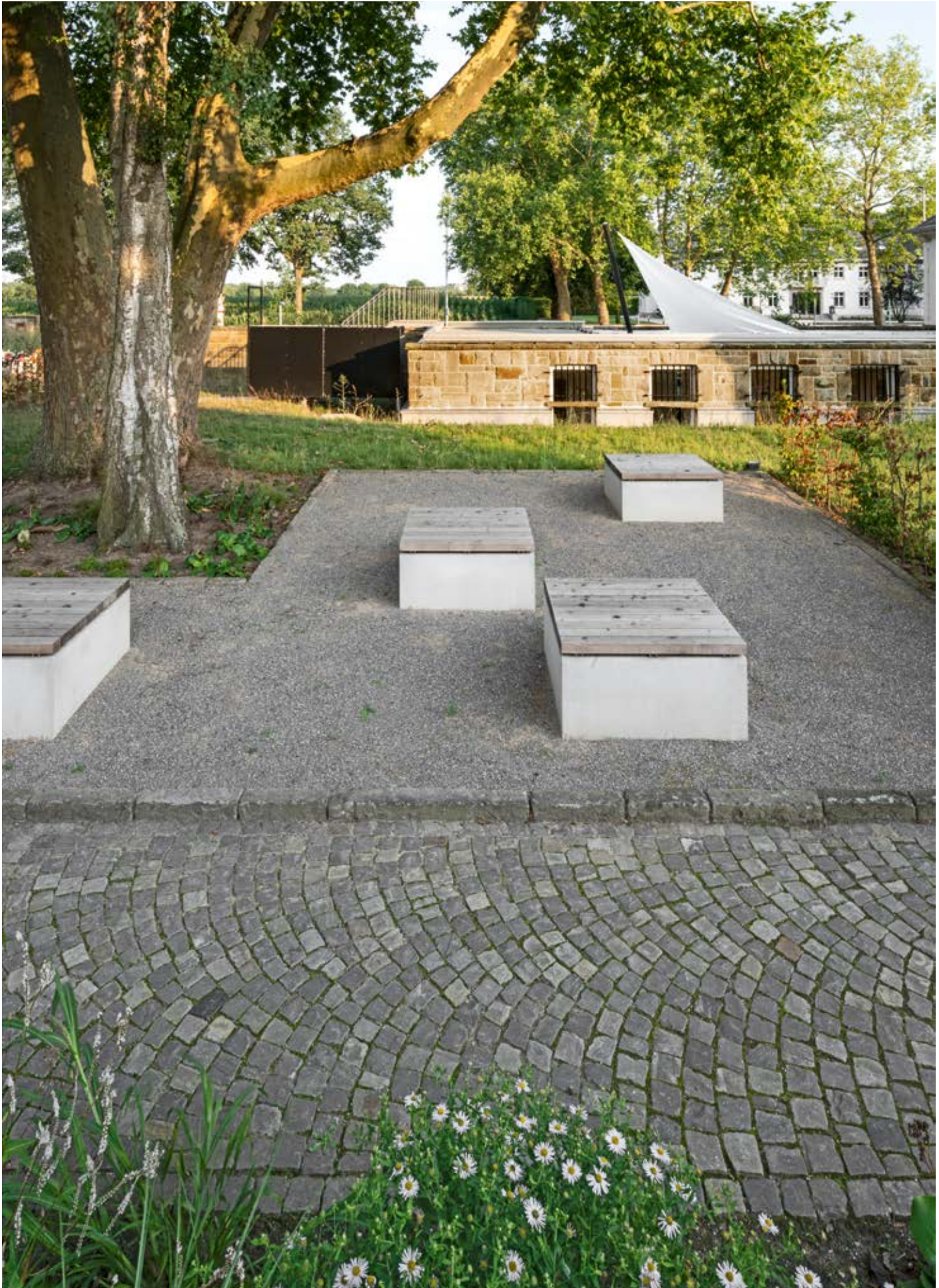
Auch in der Gestaltung des rückwärtigen Gartenbereichs kommen Historie und Modernität zusammen: Wiederverwendete, auf dem Areal vorhandene alte Natursteine 9/11 sind kombiniert mit Betonblöcken als Sitzgelegenheit.
